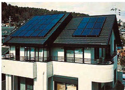
太陽光発電システム Photovoltaic generation system
