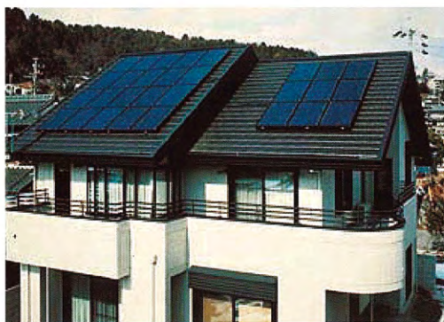
太陽光発電システム Photovoltaic generation system
