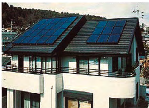
太陽光発電システム Photovoltaic generation system
