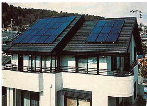
太陽光発電システム Photovoltaic generation system
